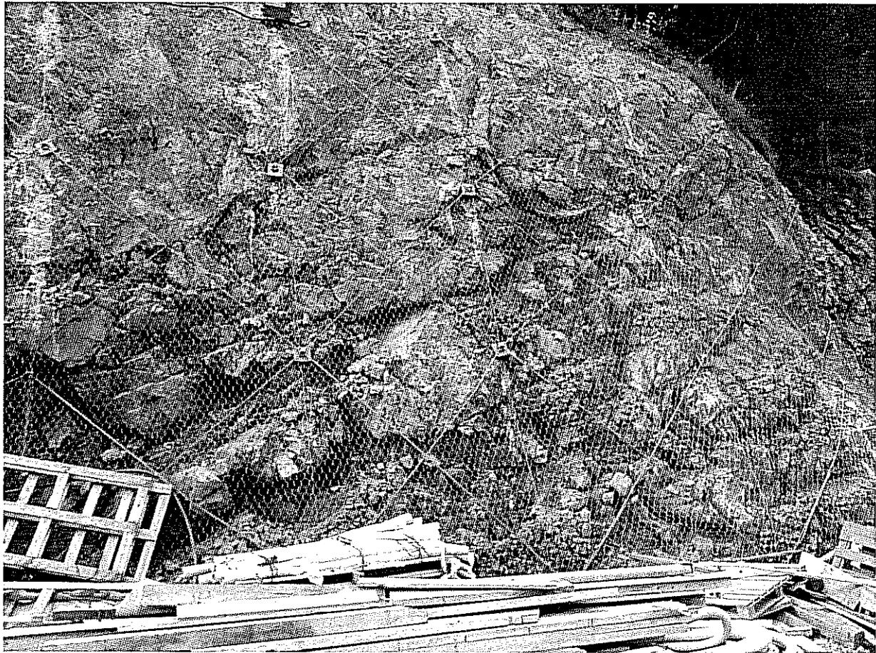
Parete con disaccorpamento visibile della roccia dopo un anno della posa delle reti
