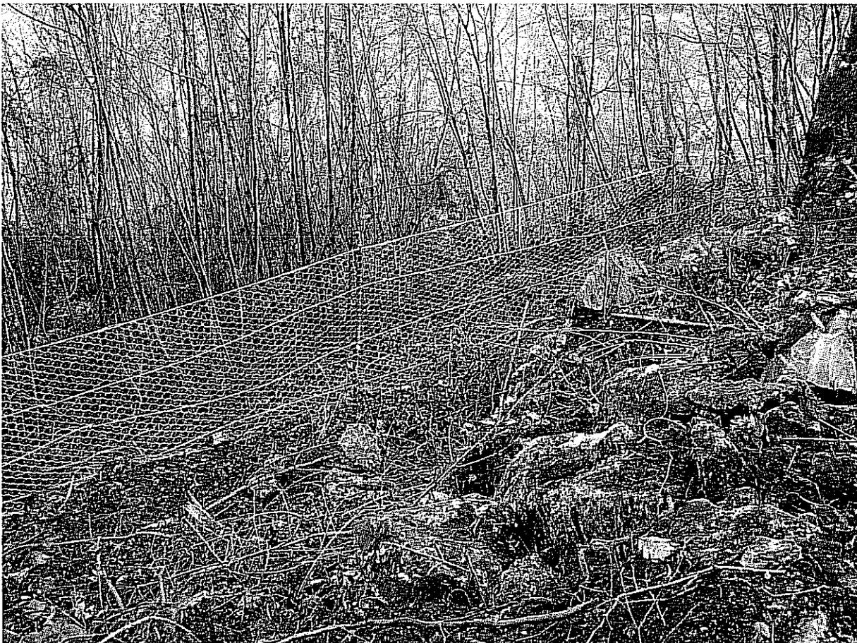
**Particolare reti provvisorie a protezione canale Enel e case sottostanti**
