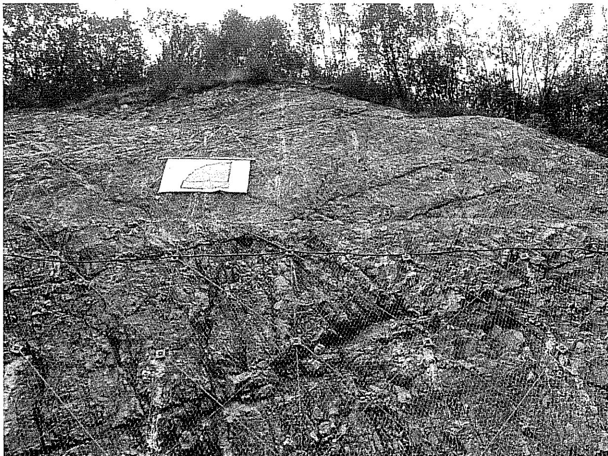
Parete di dolomia con disaccorpamento visibile della roccia dopo un anno della posa delle reti
